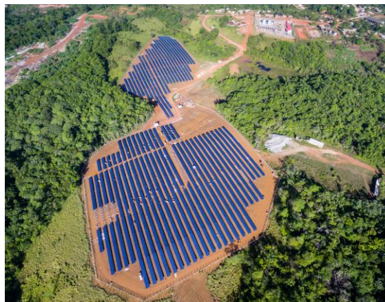
Site de la centrale solaire d'Oiapoque (Brésil)
