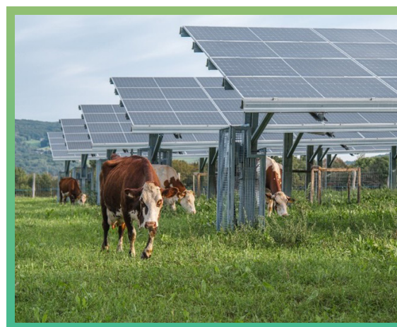
Démonstrateur agrivoltaïque de Poisy. Ce projet innovant vise à étudier les interactions entre les infrastructures photovoltaïques et l'élevage bovin
